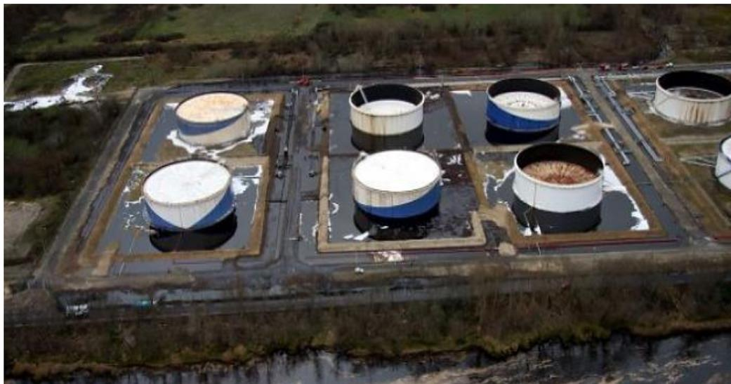
Рис. 2. Разлив нефтепродуктов в резервуарном парке
