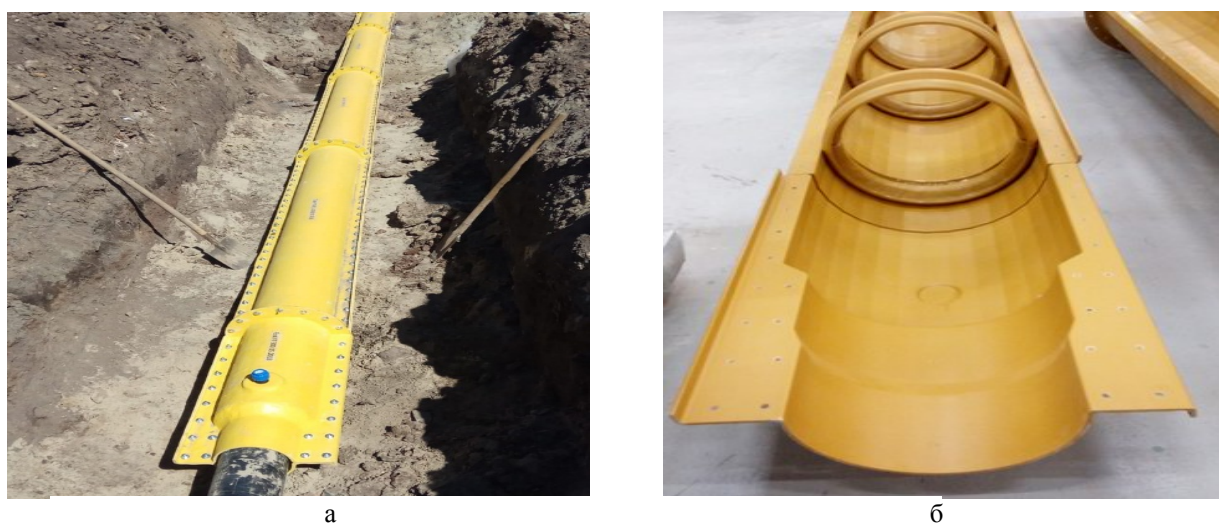
Рис. 2. Композитный защитный футляр: а – установленный на действующий газопровод; б – в разрезе
