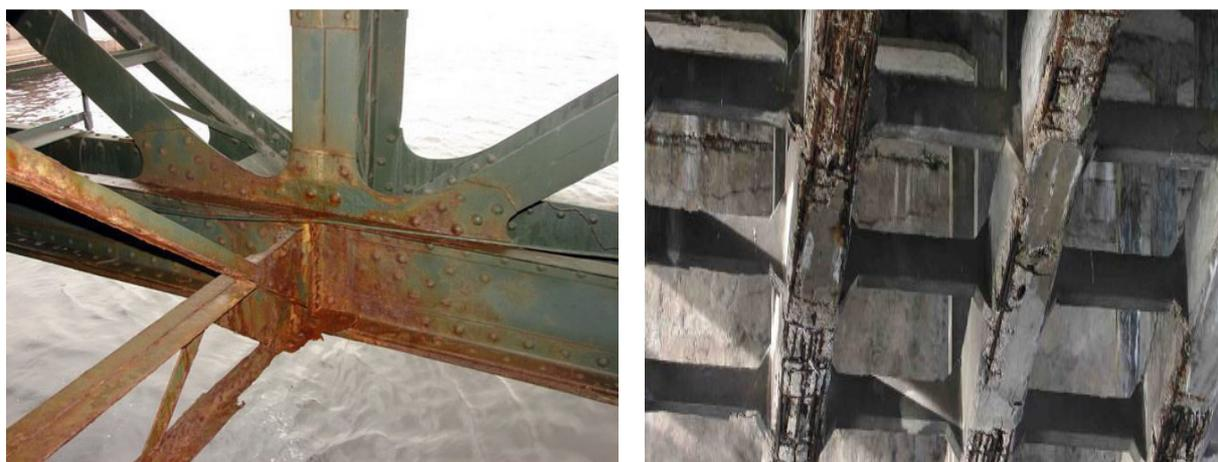
**Рис.1.** Железобетонные и металлические мостовые конструкции покрытия пораженные коррозией
