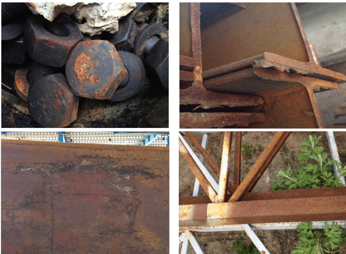
**Рис.3.** Повреждение металлических конструкций коррозией на примере различных типов профиля
