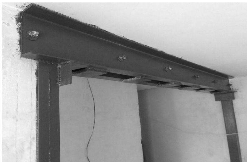
Рис. 3. Монтаж горизонтального усиливающего швеллера
