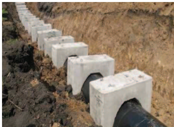
Рис. 2. Железобетонный утяжелитель типа 1-УБКм
