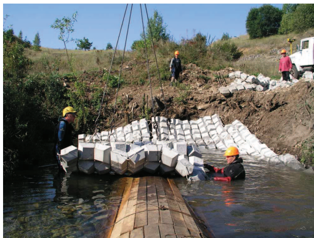
Рис. 9. Защита трубопровода
