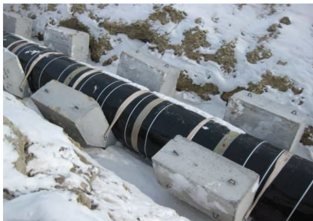
Рис.1. Железобетонный утяжелитель типа УБО
