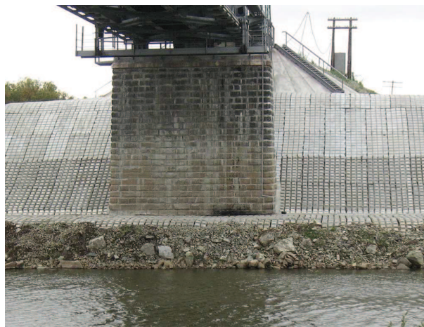
Рис. 8. Защита опоры ЖД моста, р. Ирби
