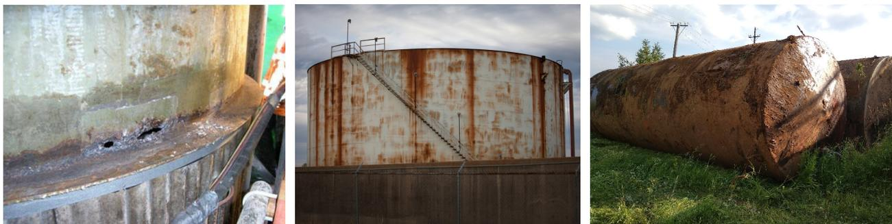
Рис. Резервуары подтверждены коррозии [9]
