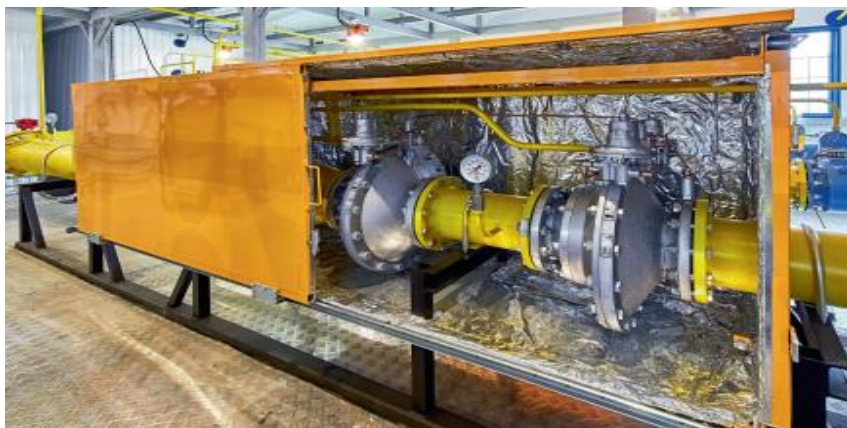
Рис. 2. Шумогасящий короб на линии редуцирования
