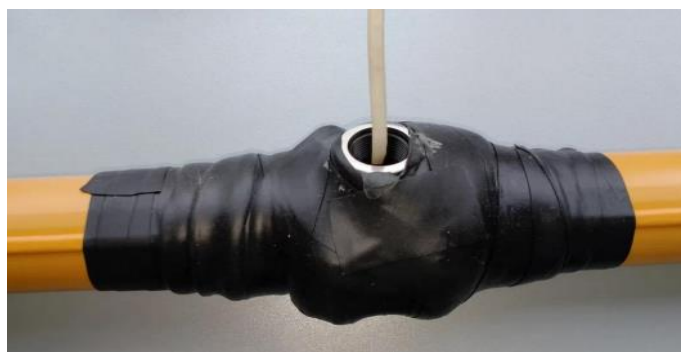
Рис. 1. Изоляция места вывода токопроводящего элемента под ковер
