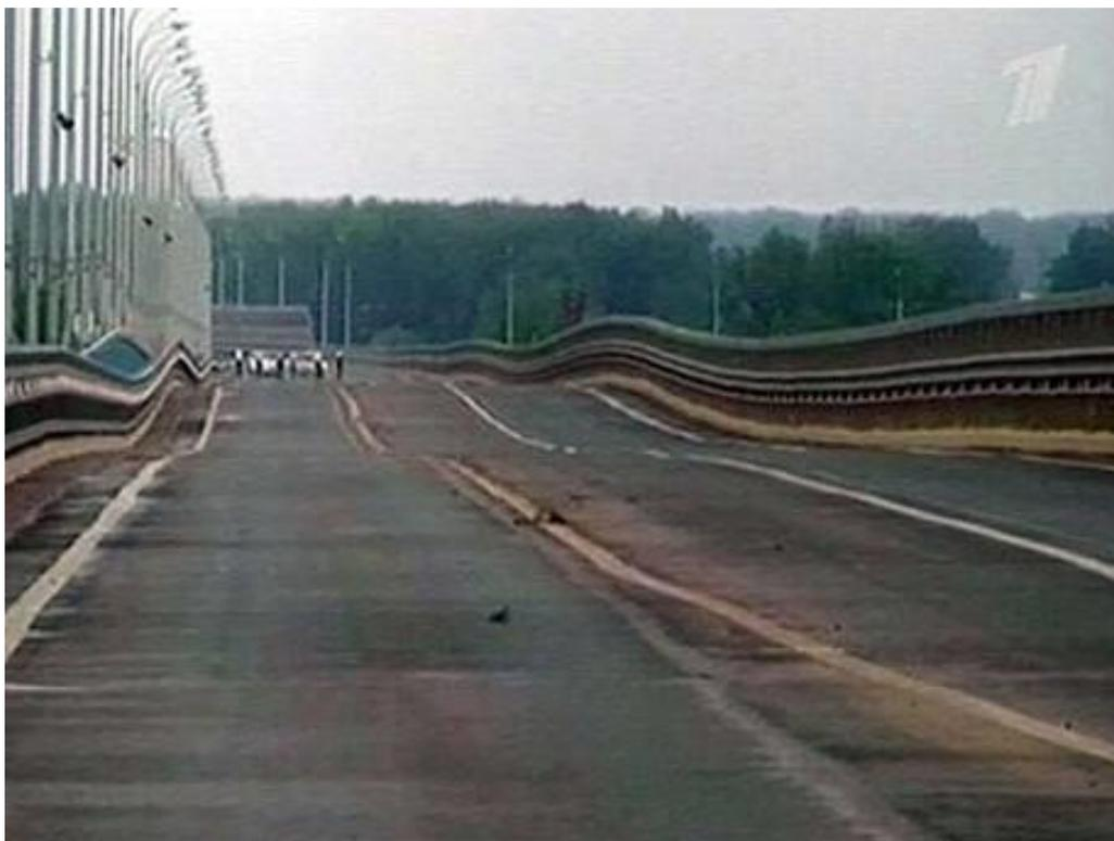
**Рис.2.** Вид на проезжую часть моста при колебаниях
