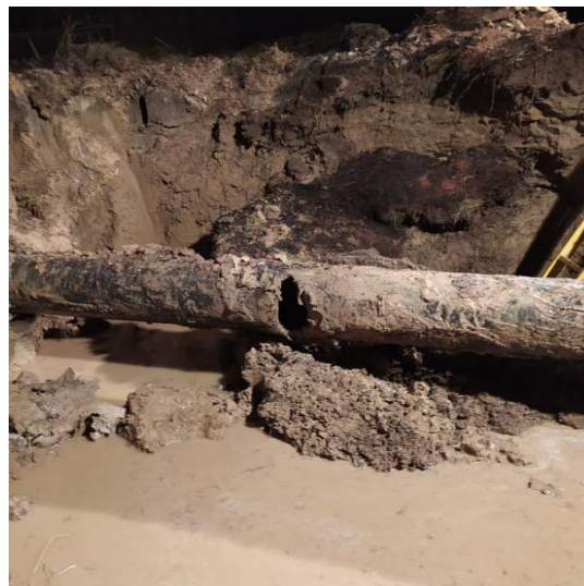
Рис. 2. Механическое воздействие на газопровод клыком-рыхлителем экскаватора (8,5 км газопровода отвода к г. Фурманов и к г. Приволжск, 13.08.2020) [3]
