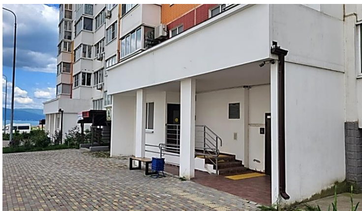
Рис. 3. Входная группа в новых жилых комплексах в городе Новороссийске с навесом и ограждением по бокам [6]
