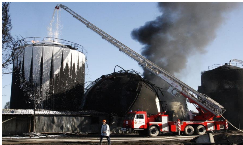
Рис. 1. Надслойный способ тушения РВС [2]
