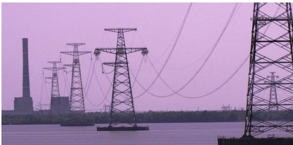
Рис. 4. Переход ЛЭП 750 кВ через Каховское водохранилище [6]
