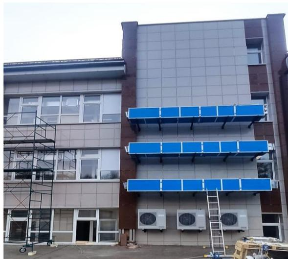
**Рис. 7.** Размещение приточного вентиляционного оборудования и наружных блоков системы кондиционирования воздуха в больнице, г. Подольск
