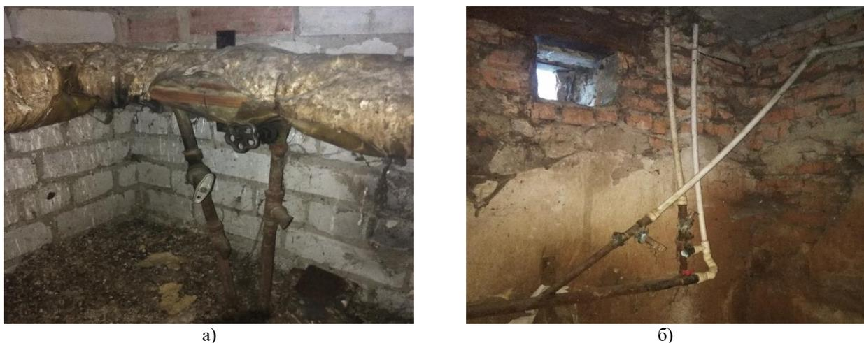
**Рис. 4.** Подключение стояков системы отопления к магистралям: а – чердак; б – подвал
