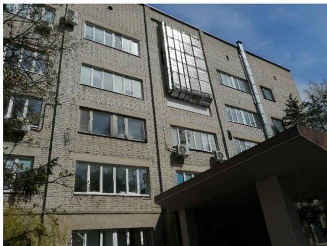
**Рис. 6.** Транзитные воздуховоды, проложенные вдоль фасада больницы, г. Воронеж
