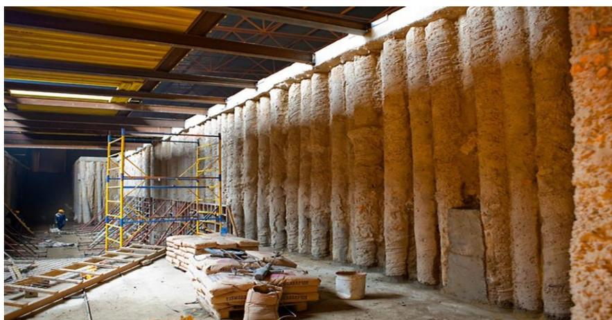
Рис. 6. Ограждение из буросекущих свай [2]
