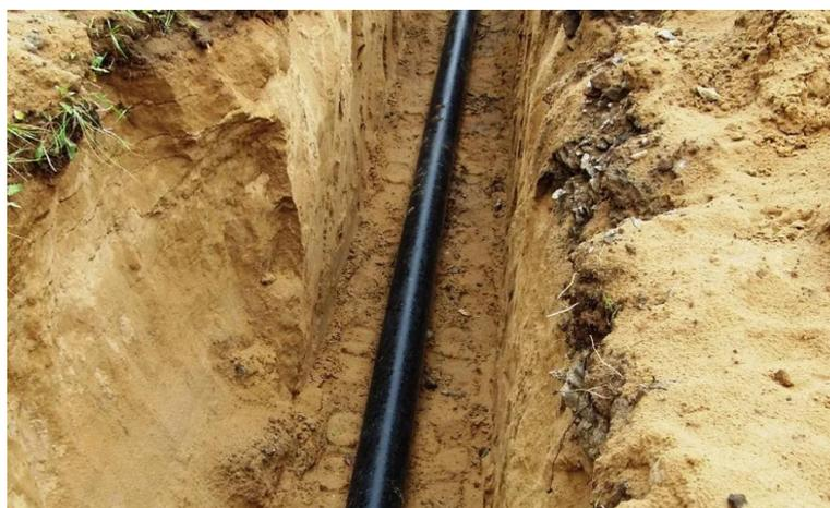
Рис. 2. Пример прокладки газопровода методом ОКМ [5]
