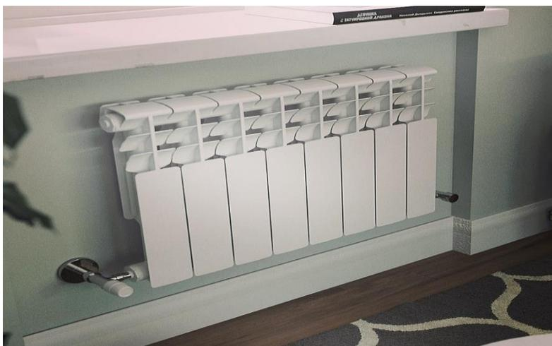
Рис. 5. Биметаллический радиатор [1]
