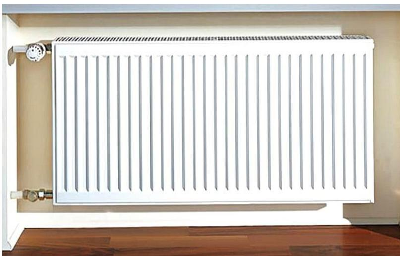
**Рис. 3.** Панельный радиатор [1]
