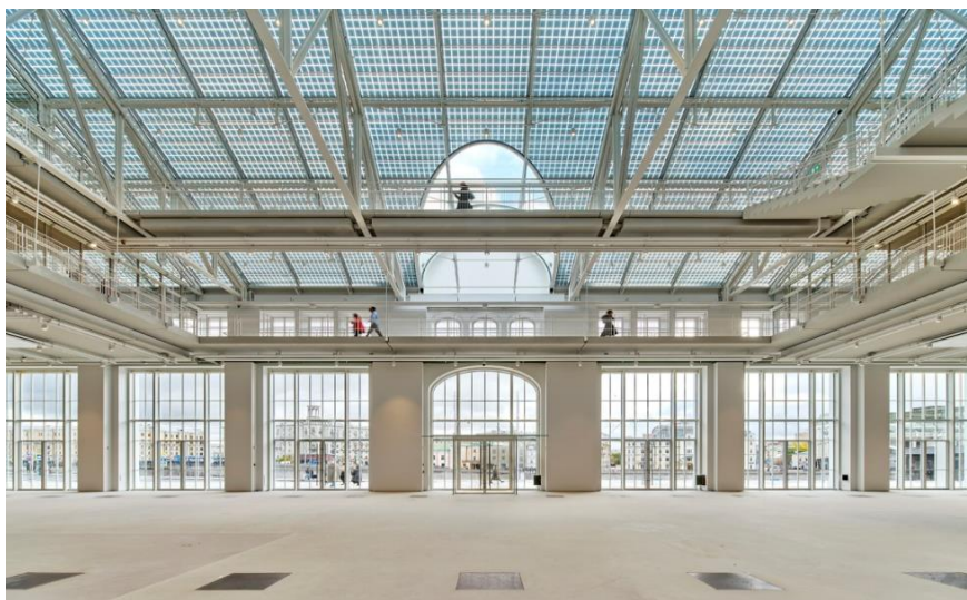
Рис. 5. Центральный зал «ГЭС-2»
