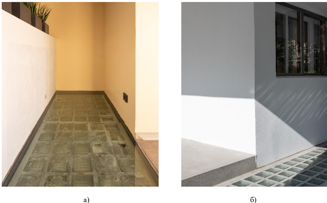
Рис. 3. Световые приемники: а – сохраненный фрагмент; б – воссозданный фрагмент
