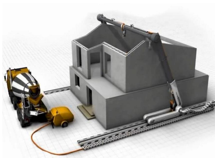
Рис. 1. Организация строительства с помощью портального 3D-принтера [2]
