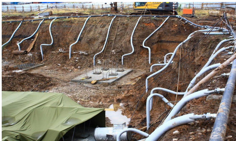
Рис. 4. Система иглофильтровых установок [2]
