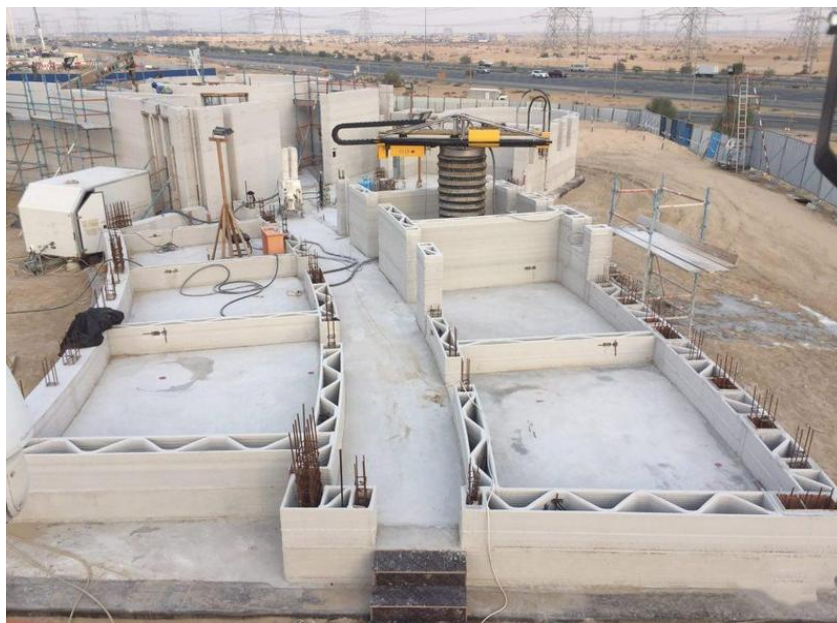
Рис. 4. Строительство с применением 3D-принтера [7]
