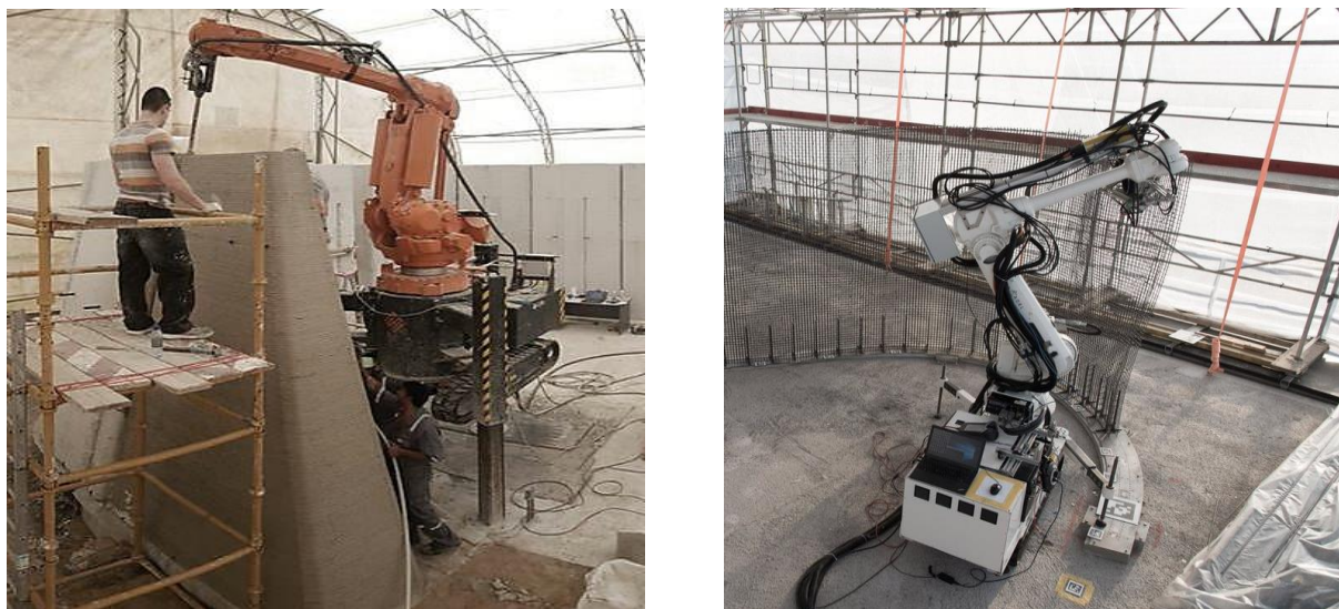
Рис. 3. Организация строительства с помощью 3D-принтера-робота [3]
