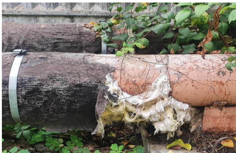
Рис .3. Тепловая изоляция из минеральной ваты (шлаковата) [9]
