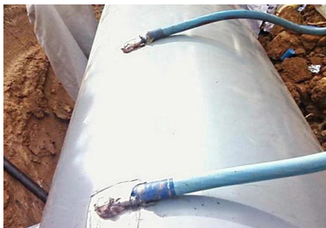
Рис. 4. Метод электрического потенциала: подключение проводников к более активным металлам [4]
