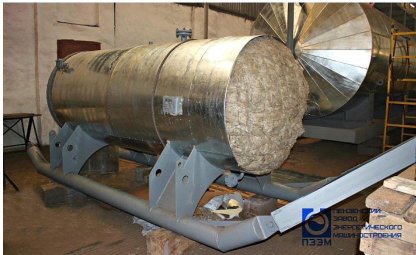
Рис.2. Устройство теплоизоляции резервуара на санях [6]
