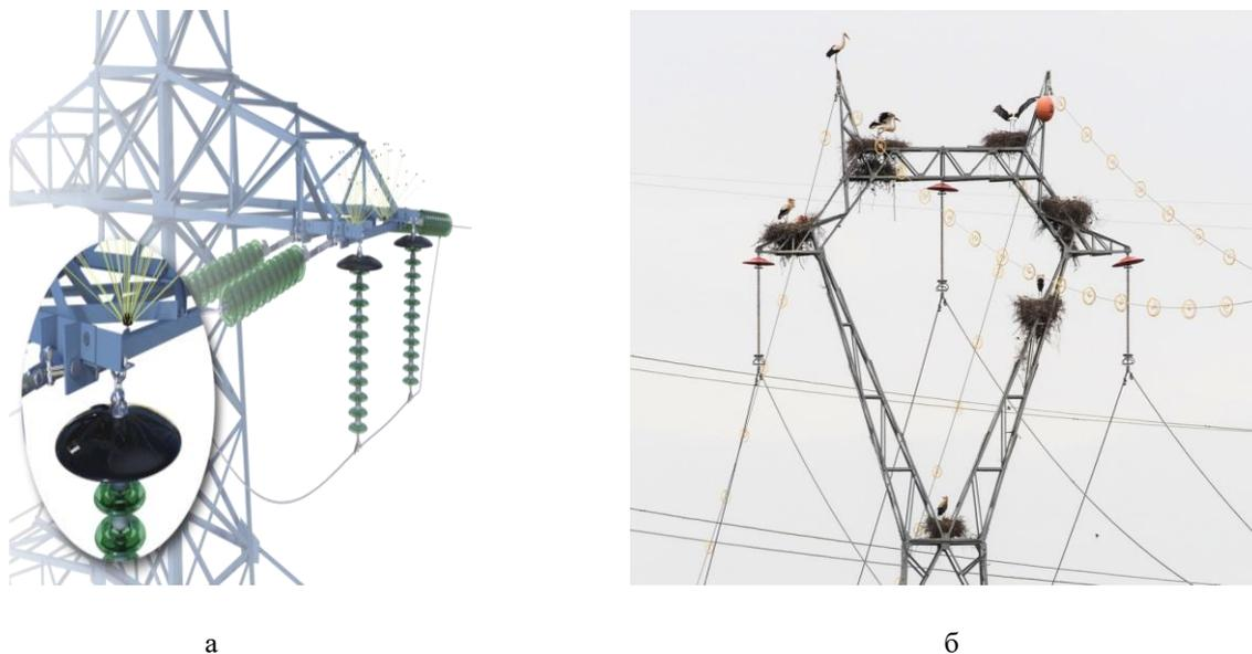
Рис. 3. Примеры ПЗУ: а – барьерного типа; б – маркерного типа
