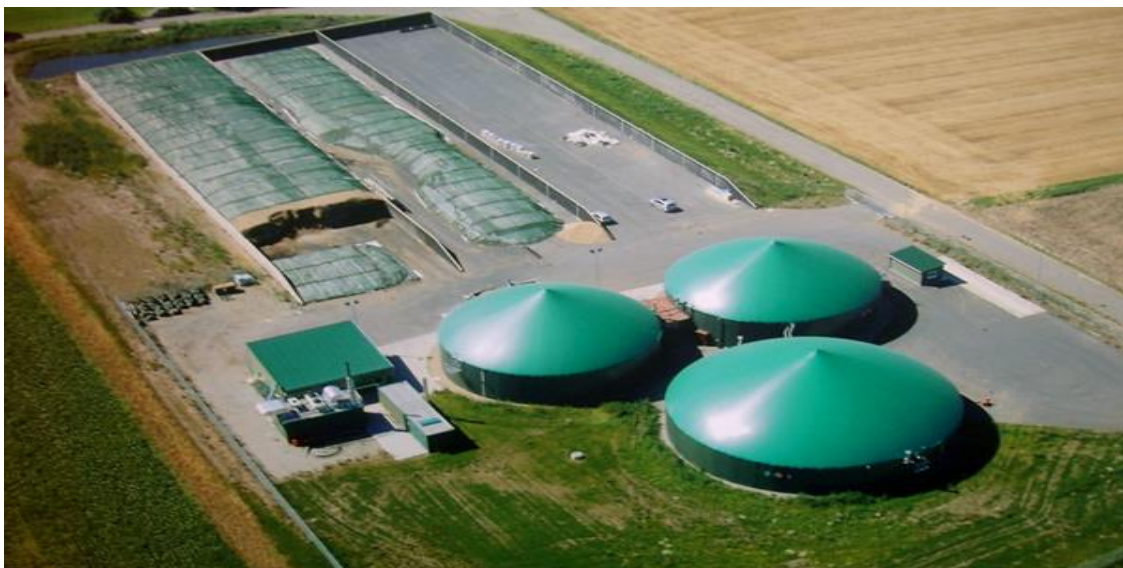
Рис. 1. Общий вид биогазовой станции
